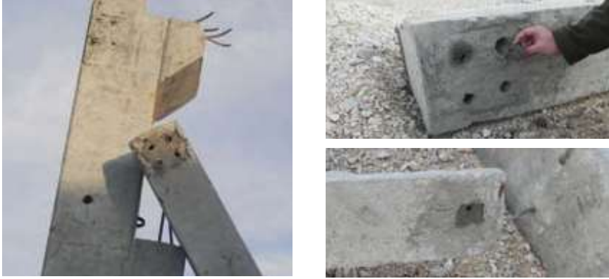
Fotoğraf 3.6 (a, b, c) - Şerbetlemenin Yetersizliğini Gösteren Detaylar
