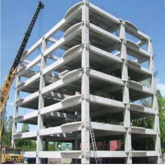
(a) Ard Germeli Birleşime Sahip Prefabrik İskelet
