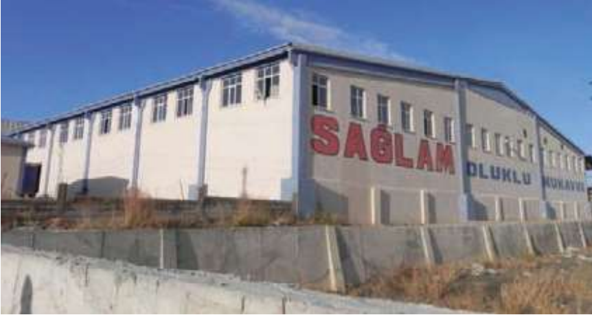
Fotoğraf 3.1 - Hasarsız Sanayi Yapısı
